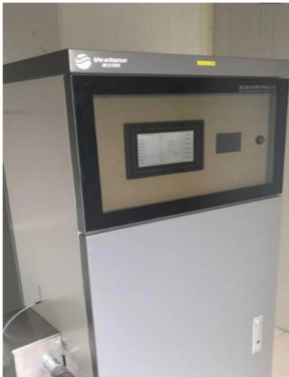
图 4-8 在线监测设备图（含镍废水处理系统）
