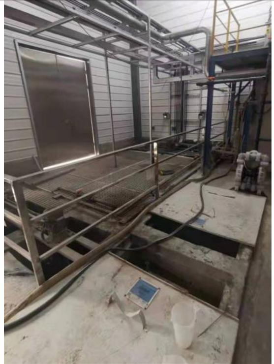
图 3-3 水喷淋塔洗气废水、蒸发冷凝水、高浓度预脱脂废水处理设施
