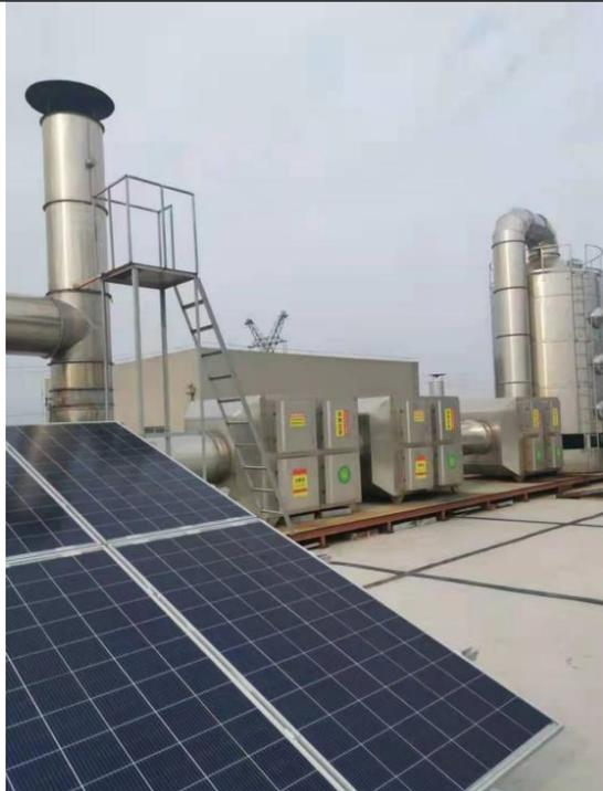
图 3-8 电泳涂装、固化工序废气、天然气燃烧烟气处理设施
