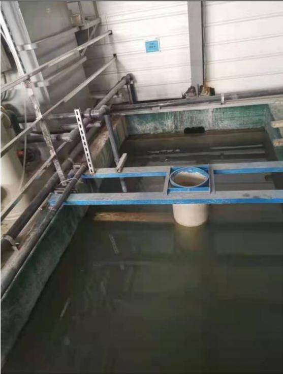
图 3-4 水喷淋塔洗气废水、蒸发冷凝水、高浓度预脱脂废水处理设施
