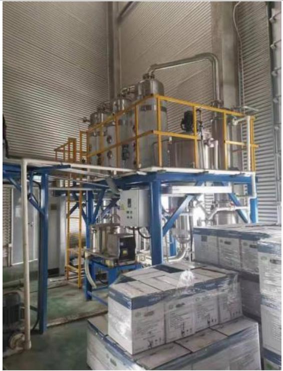
图 3-2 高浓度主脱脂废水、高浓度硅烷化处理废水设施
