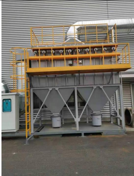
图 3-9 切割、打磨、焊接废气处理装置
