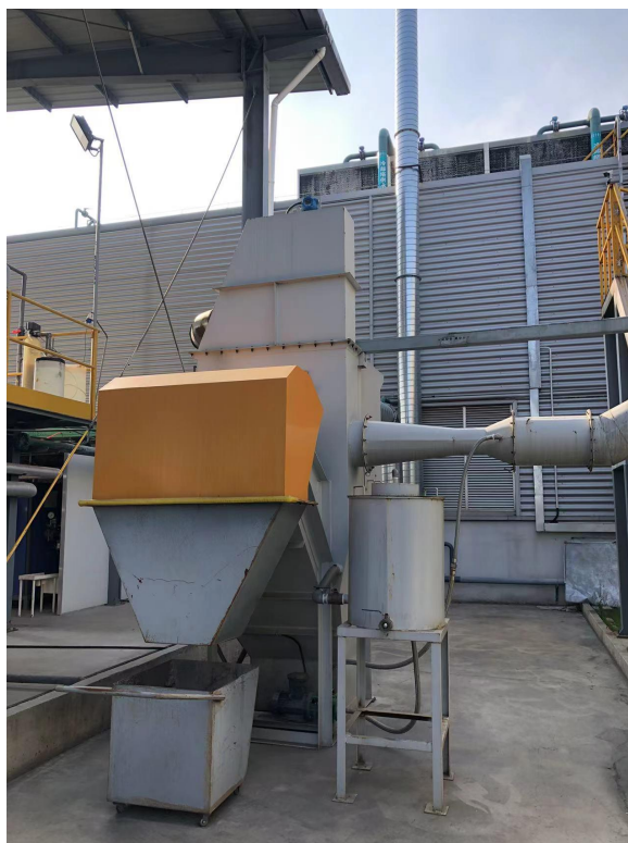
图 3-4 抛丸废气处理设施图
