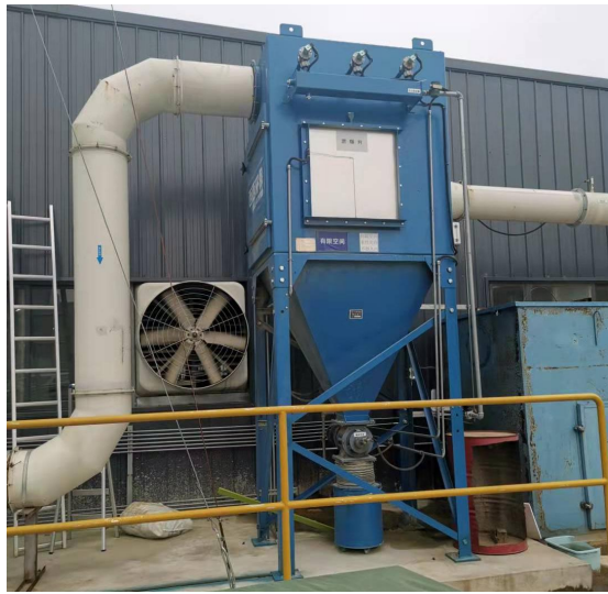
图 3-4 玻璃钢锯切废气处理装置
