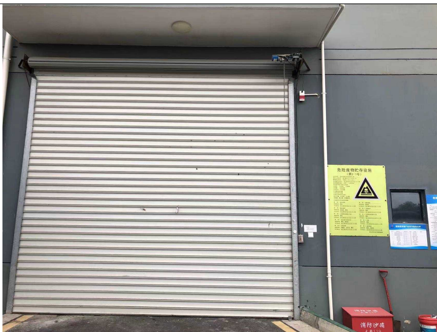
图 3-4 危废暂存场所
