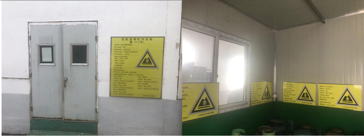
图 3-4 危废暂存场所
