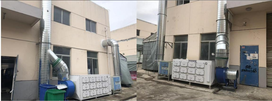
图 3-2 废气处理设施（左为印刷、挤出，右为复膜、制袋）
