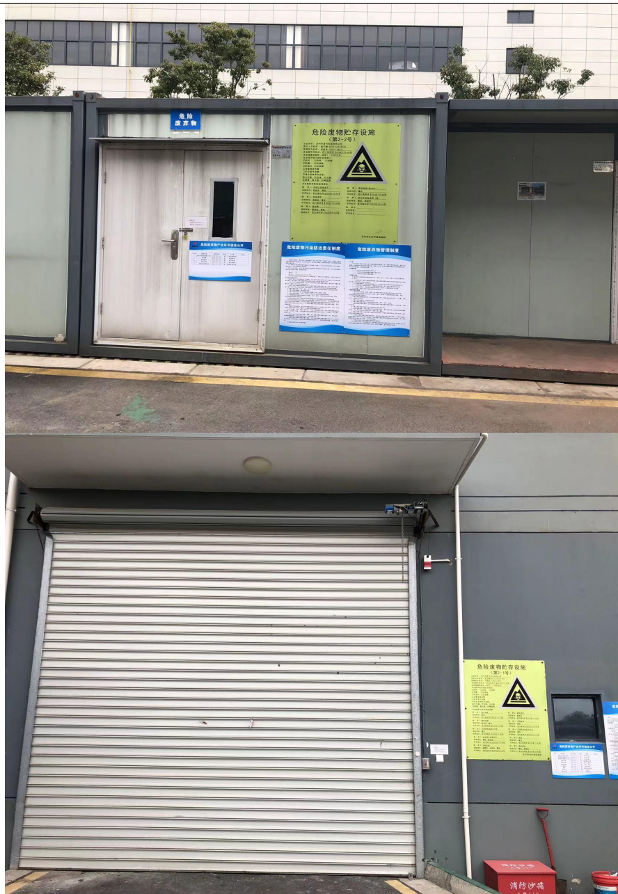
图 3-4 危废暂存场所
